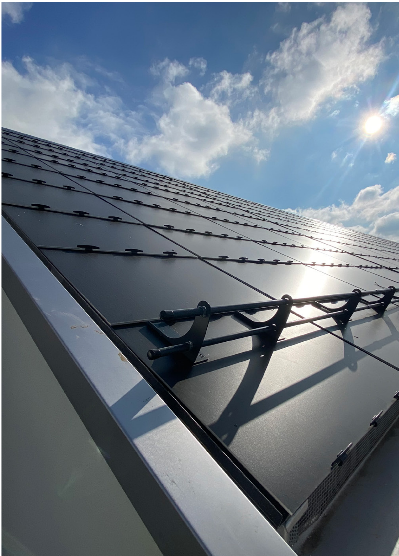
DAS NEUE, MIT ALUMINIUM-VERBUNDPLATTEN GEDECKTE DACH STRAHLT MIT DER SONNE UM DIE WETTE.
