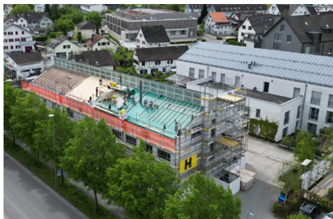
VORN DAS ATELIERGEBÄUDE WÄHREND DER SANIERUNG. DAS DAHINTER GELEGENE WOHNHAUS WIRD 2025 SANIERT.
